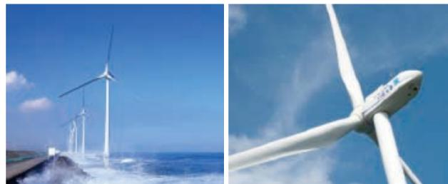
右／「ダウンウインド方式」なので、この写真では風は右から左に向かって吹いている。左／2010年7月から稼働している『ウインド・パワーかみす洋上風力発電所』。海岸から50メートルの洋上に建設し、棧橋で陸上とつながっているためメンテナンスもしやすい。
