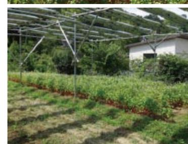
上／千葉県市原市にある「ソーラーシェアリング」の実証試験場。ソバを栽培する農地の上に、格子状に太陽光パネルを設置。左／長島さんによれば、パネルの陰になる遮光率の高い部分に植えた作物も、生育の差は見られないようだ。www.d3.dion.ne.jp/~higashi9/sola1.htm
