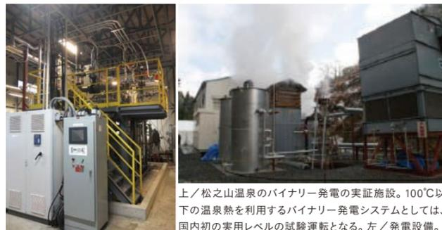
上／松之山温泉のバイナリー発電の実証施設。100℃以下の温泉熱を利用するバイナリー発電システムとしては、国内初の実用レベルの試験運転となる。左／発電設備。
