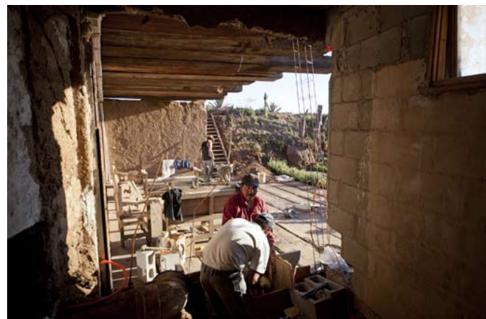
上/アレハンドロの建築プランノートには奇妙なカラージュや落書きもいっぱい。その遊び心こそが豊かなアイデアに繋がる。中/クラウディアの家具工房では、職人たちがリサイクル木材家具を作製中。下/家の地下に新たな部屋を建てるため、土壁を固めている。
