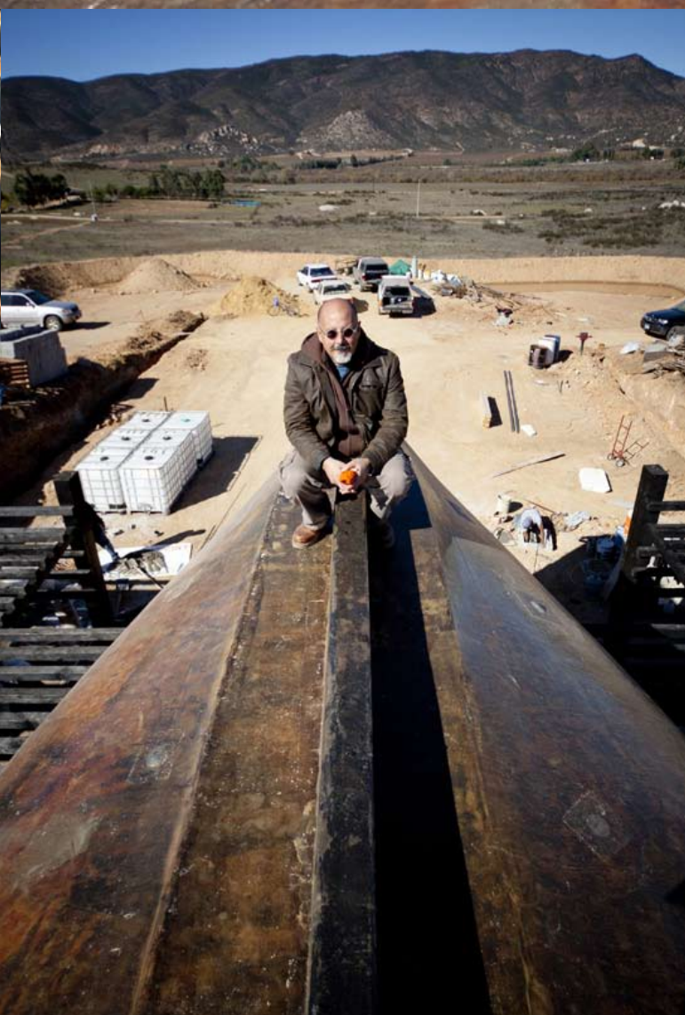
上／建設中のワイナリー、オンブリゴ。土を削りだして造った建物の上に廃船の屋根をつけた。右上／玄関部の外壁の装飾には、屋根で使った船の板を剥がしたものを張りあわせた。昔の塗装を活かして使用。右下／建物内部。メガネの廃棄レンズが明かり取りの窓に。左／「この船のように、地域の将来もひっくり返したい」とアレハンドロさん。
