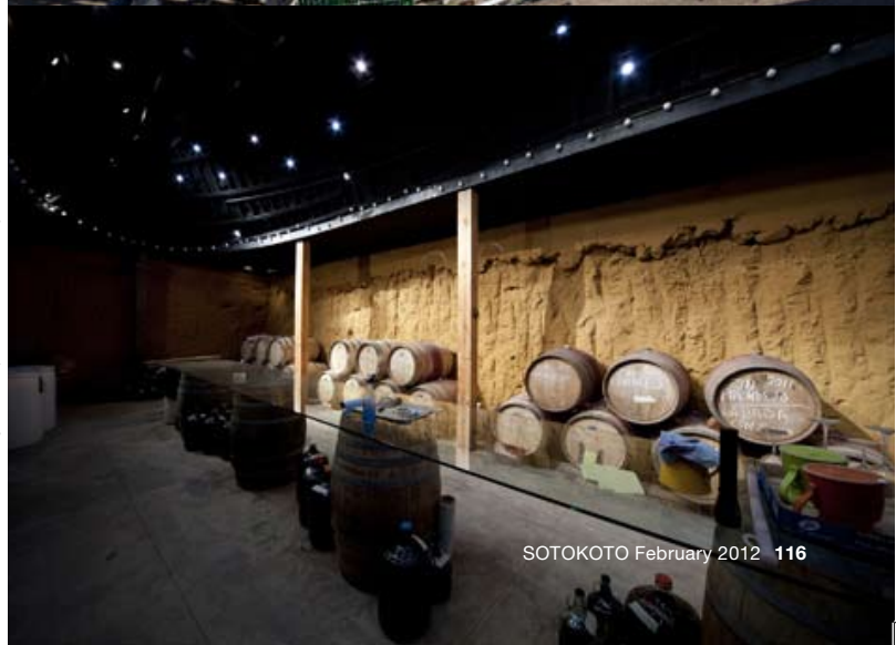
上／建設中のワイナリー、オンブリゴ。土を削りだして造った建物の上に廃船の屋根をつけた。右上／玄関部の外壁の装飾には、屋根で使った船の板を剥がしたものを張りあわせた。昔の塗装を活かして使用。右下／建物内部。メガネの廃棄レンズが明かり取りの窓に。左／「この船のように、地域の将来もひっくり返したい」とアレハンドロさん。
